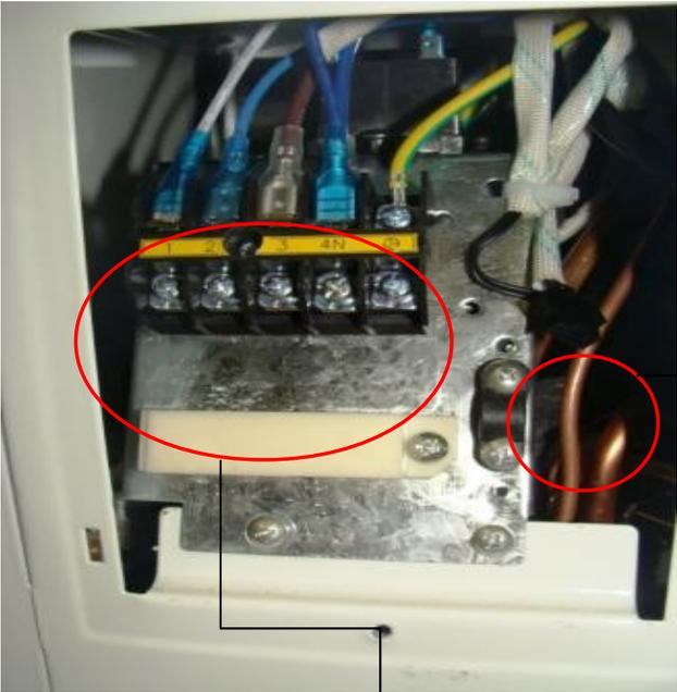
Connexion sondes de température PAC par câble blindé (fourni > 7 m)
